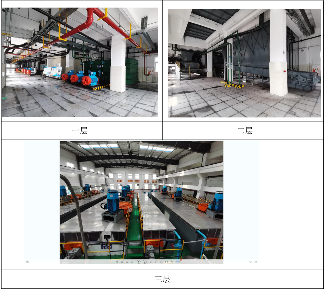
图 3.8-6 浮选压滤车间现场生产图
