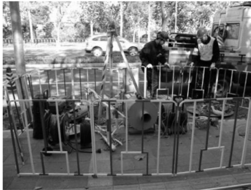
图 4-2 作业现场围挡
