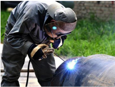
焊条电弧焊
