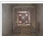
电梯井道内软质防护示意图（底视）
