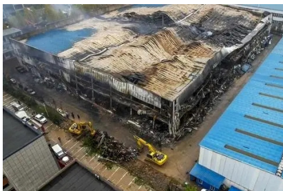
事故烧毁的厂房
