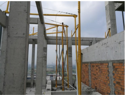
非标吊篮安装示意图
