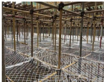
模板支撑架水平安全兜网实景图
