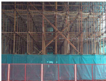
模板支撑架水平安全兜网实景图
