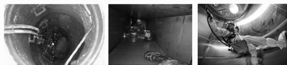
管道修复作业
