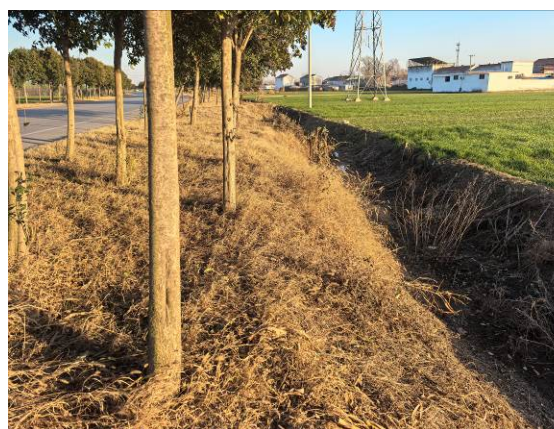
场外公路区土质排水沟（2）
