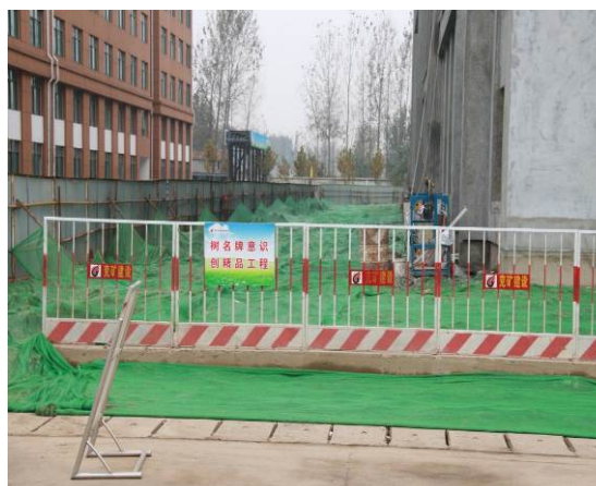
裸露地面临时苫盖 (5)
