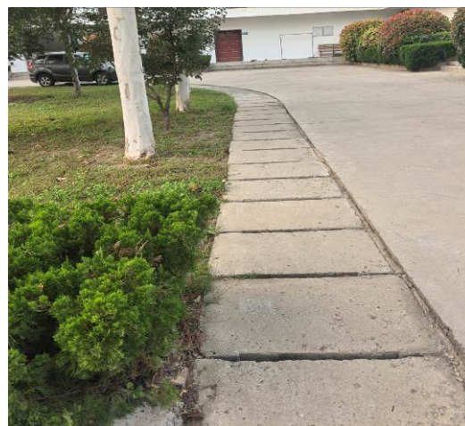
工业场地区盖板排水沟 (4)
