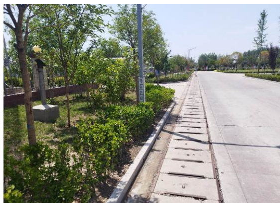
工业场地区盖板排水沟 (1)
