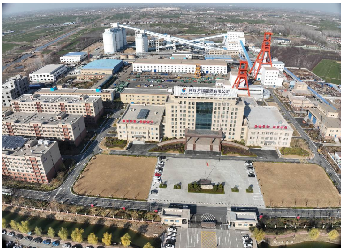
图 1-2 工业场地区航拍图
