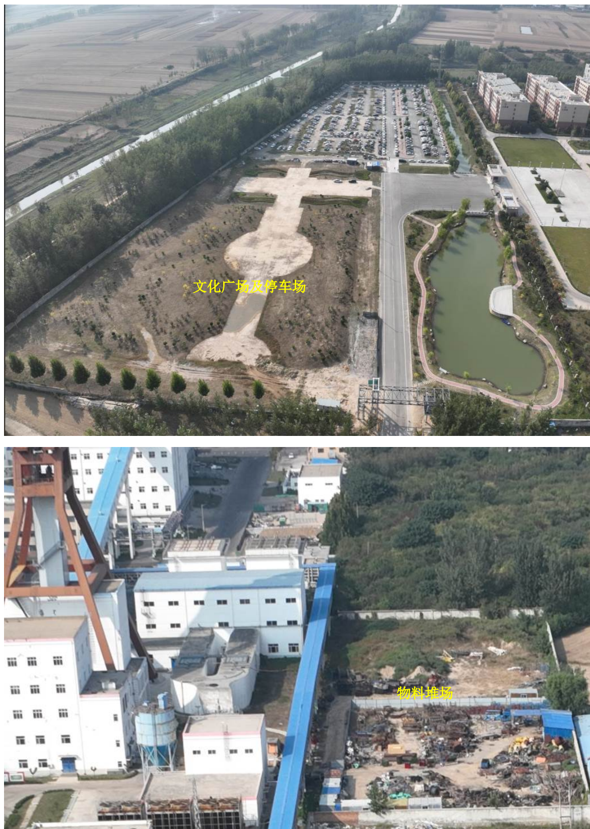
图1-5 南部文体广场停车场及东部物料堆场区平面图及航拍影像
