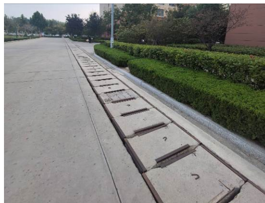
工业场地区盖板排水沟 (2)
