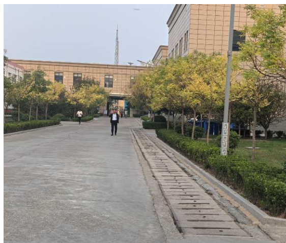
工业场地区盖板排水沟 (3)
