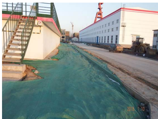
裸露地面临时苫盖 (1)
