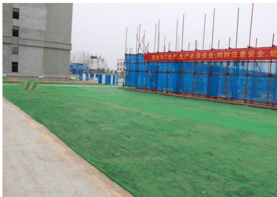
裸露地面临时苫盖 (4)
