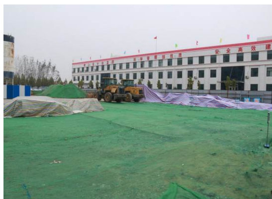
裸露地面及临时堆土临时苫盖 (3)
