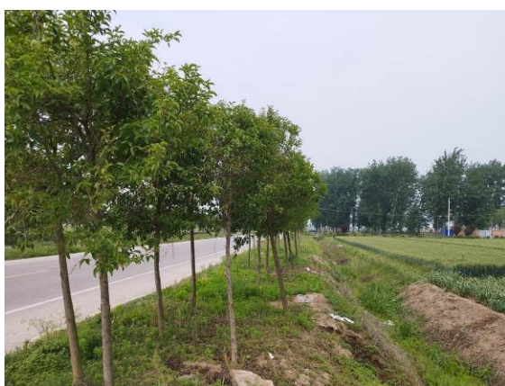
场外公路区土质排水沟（1）
