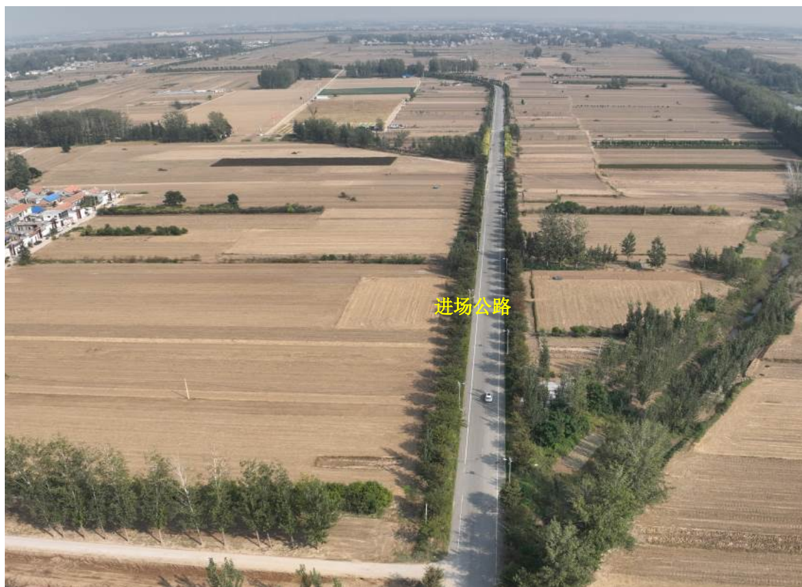
图1-3 场外道路区航拍影像
