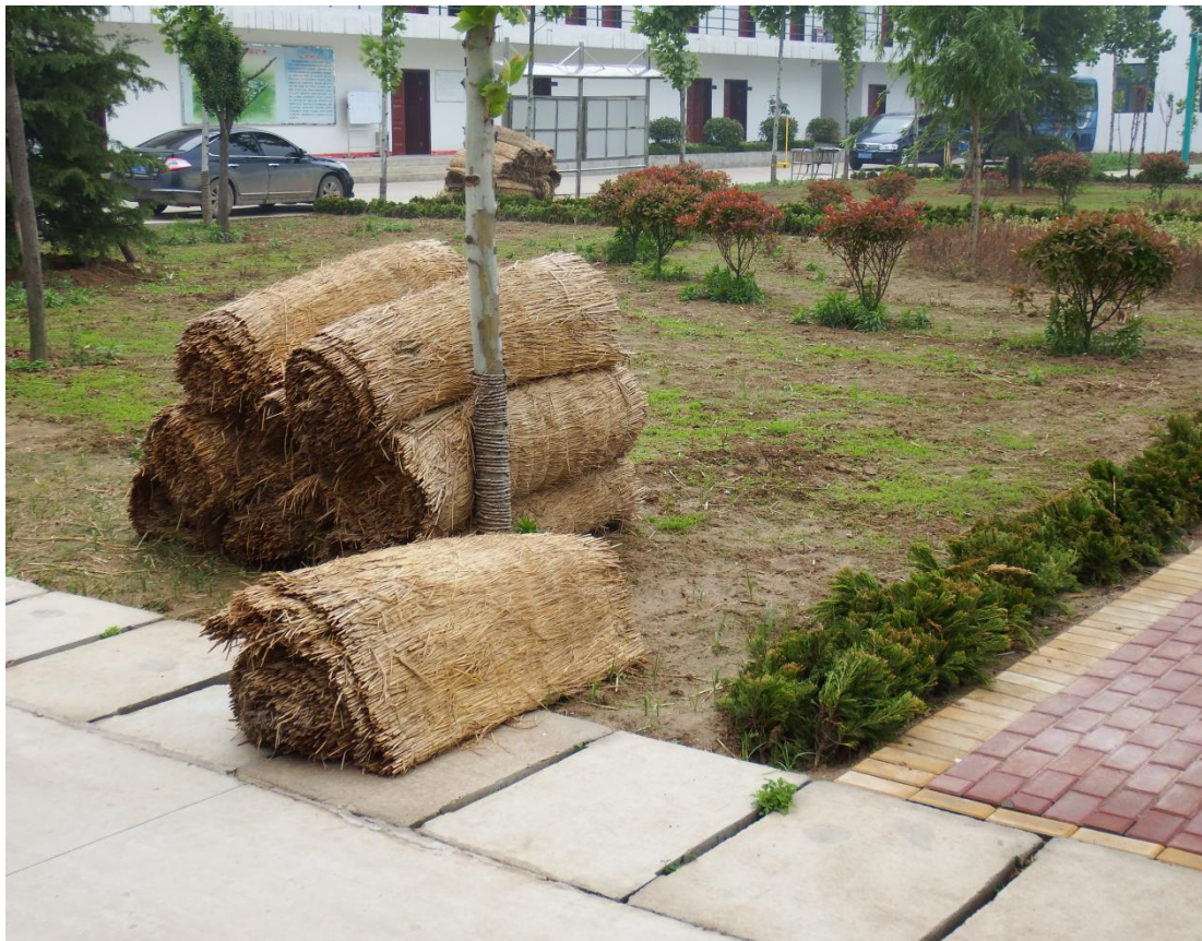
施工期临时防护措施
