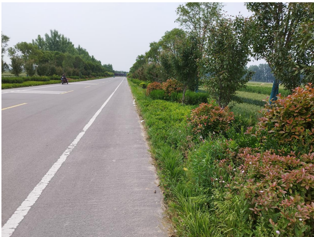
场外公路区植物防护措施
