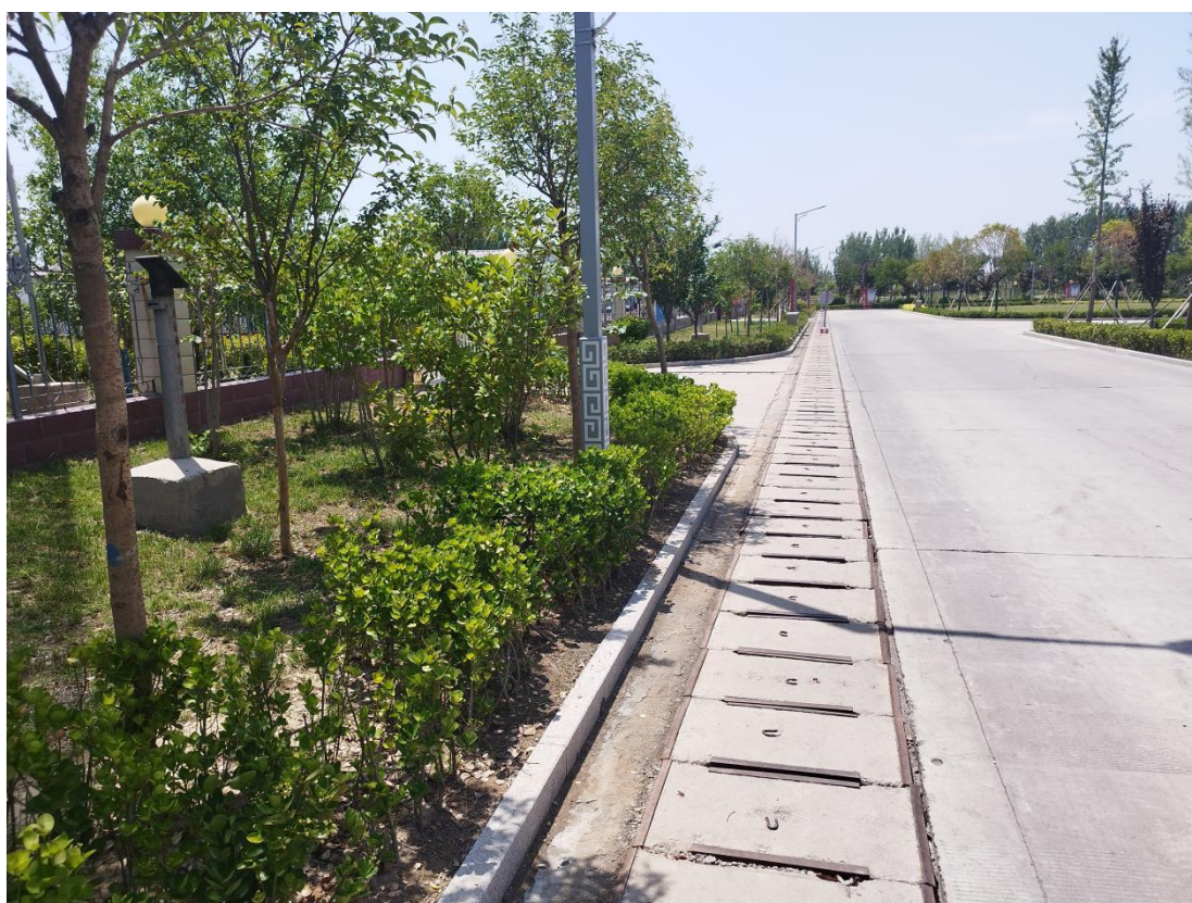
工业场地区南部盖板排水沟
