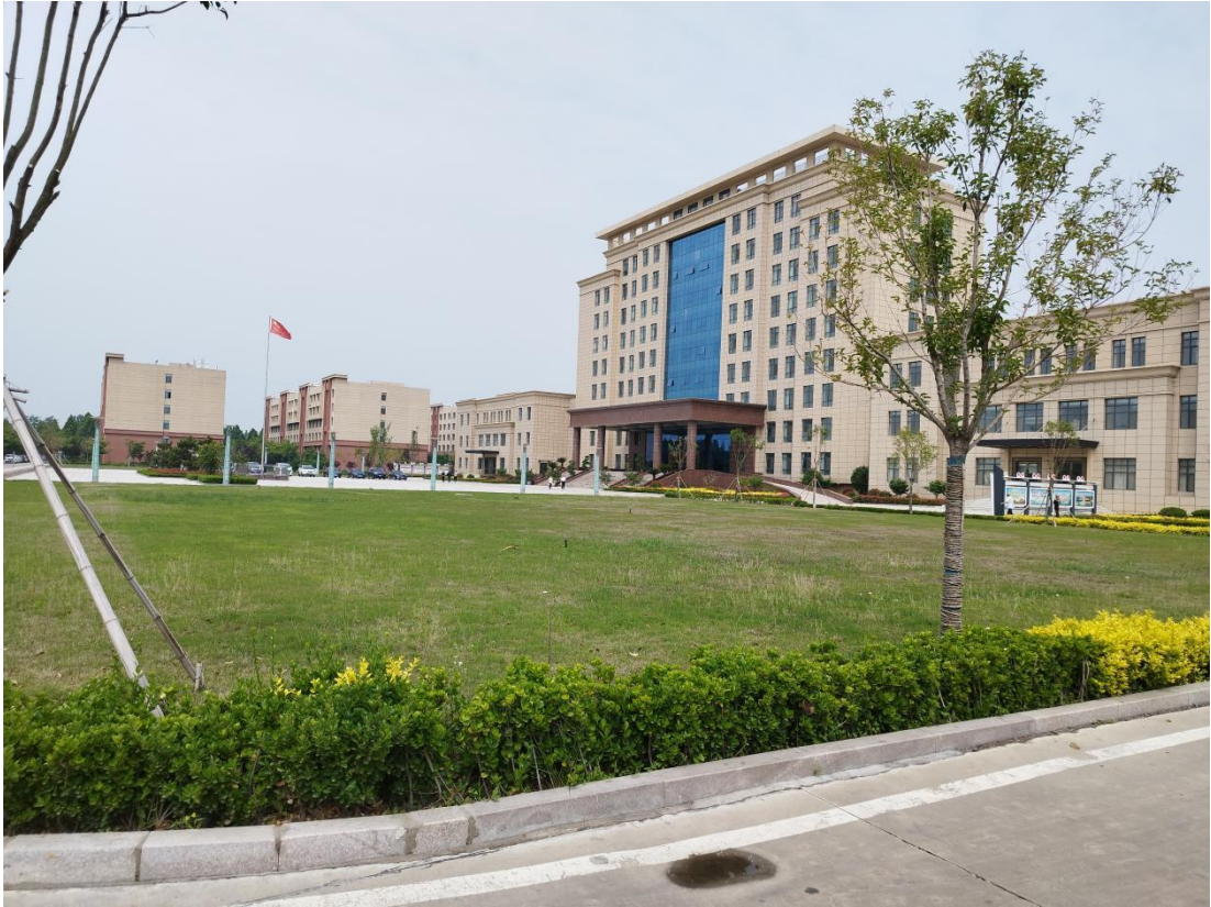
办公楼前植物防护措施
