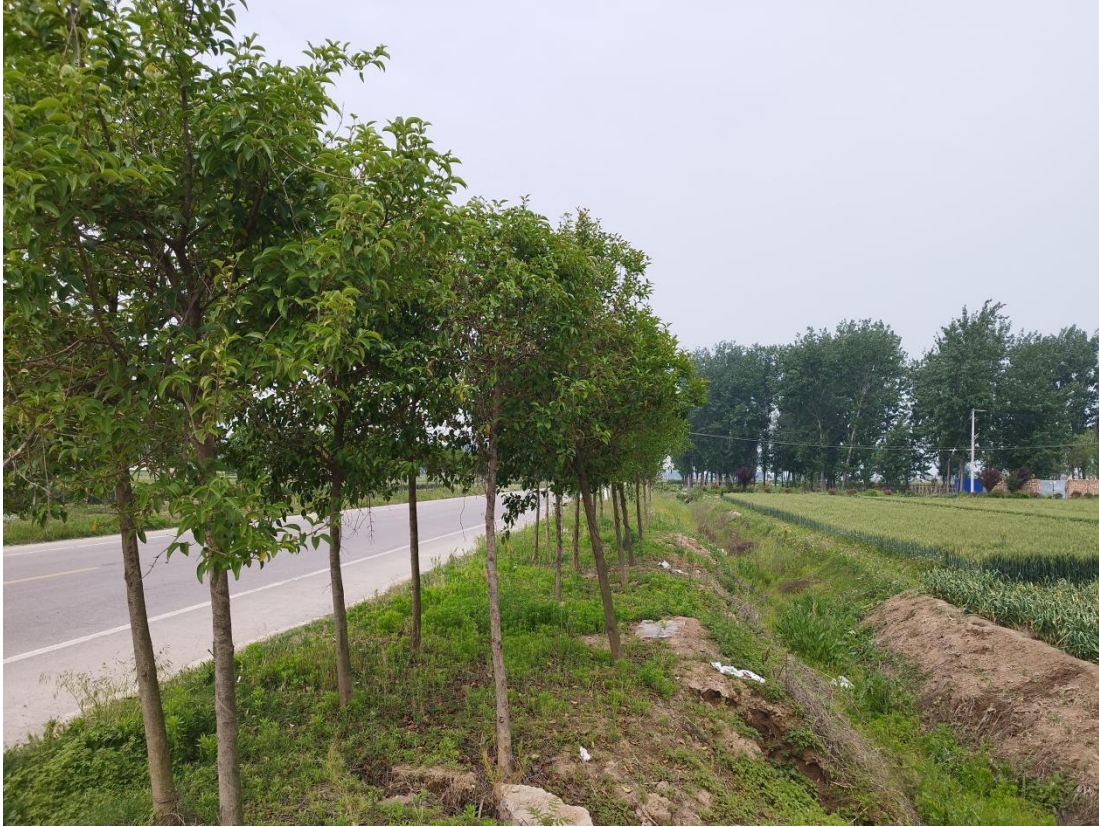
场外公路区土质排水沟
