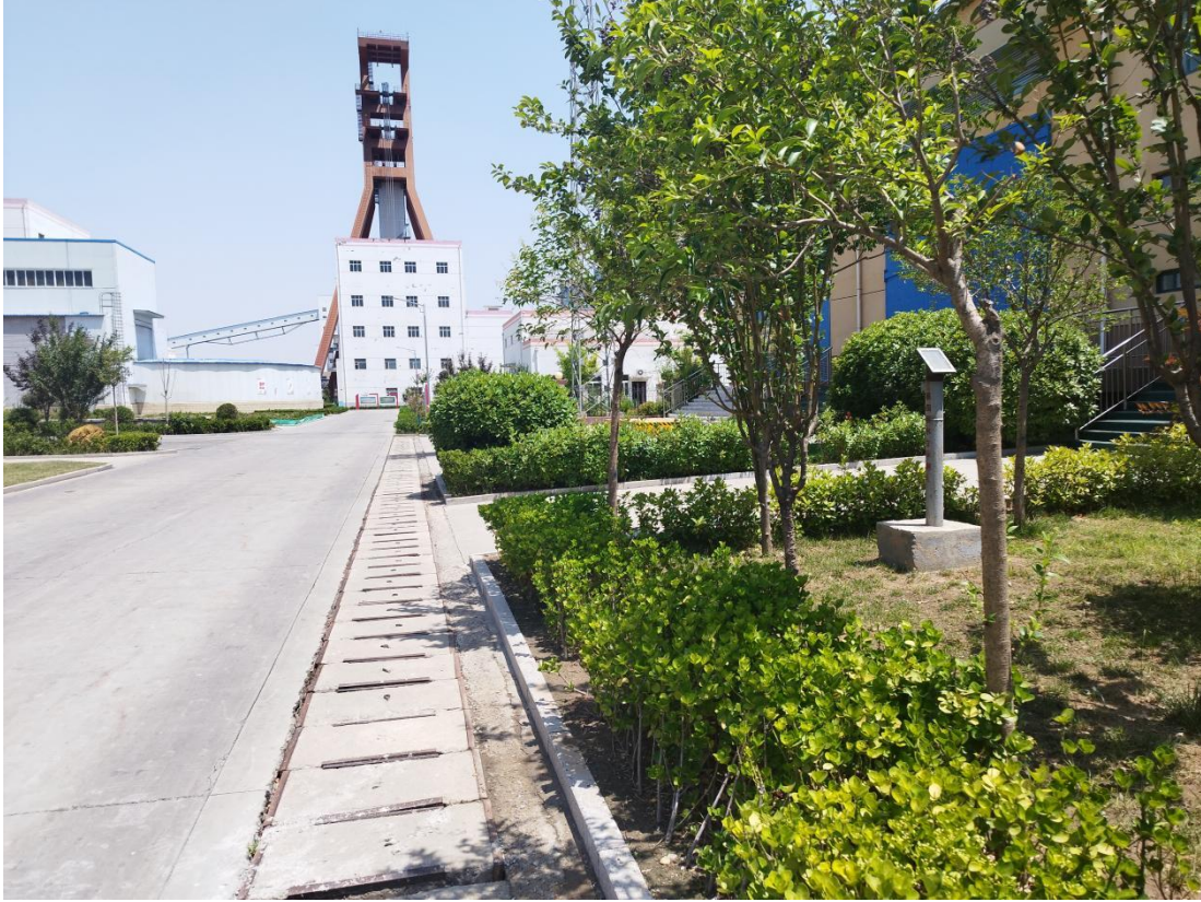
主井周边盖板排水沟
